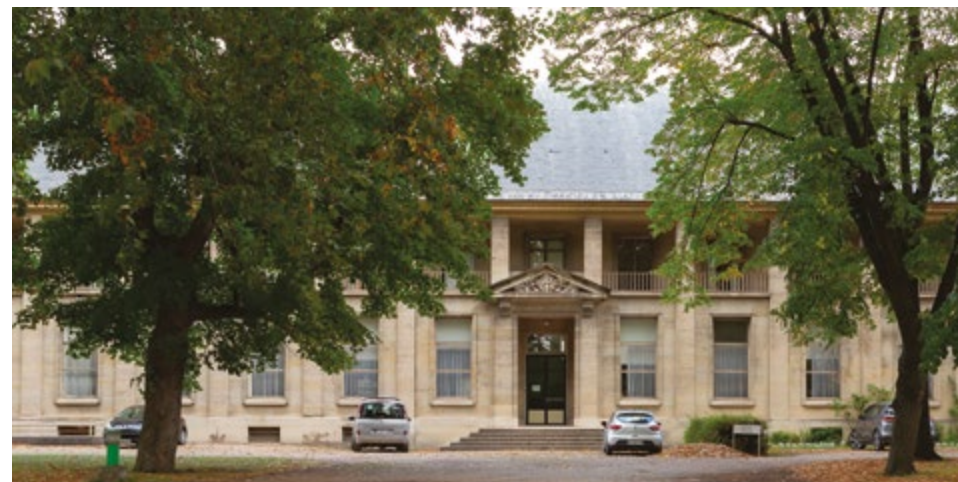
Maison d'éducation de Saint-Denis, bâtiment des archives © Laurence Von Der Weid
